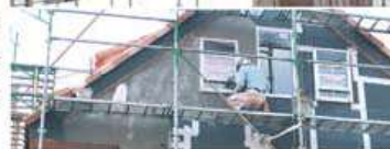
STEP9-2 外壁 ※モルタルの場合
