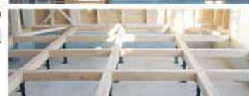
3尺桁組工法(床組)
